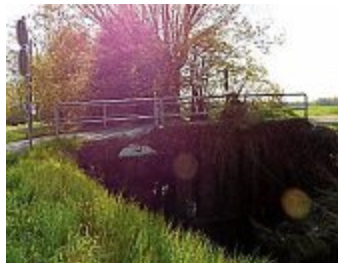
An der Straße Auf der Mede wird die Brücke erneuert. FOTO: GUS
