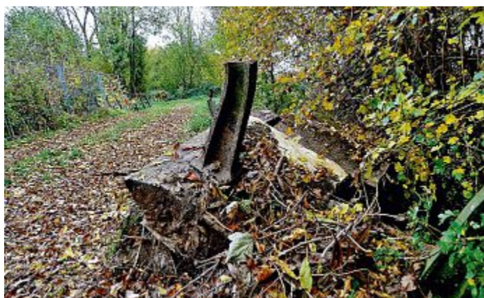
Ein Seitenteil der Brücke ist nur noch Schrott.
